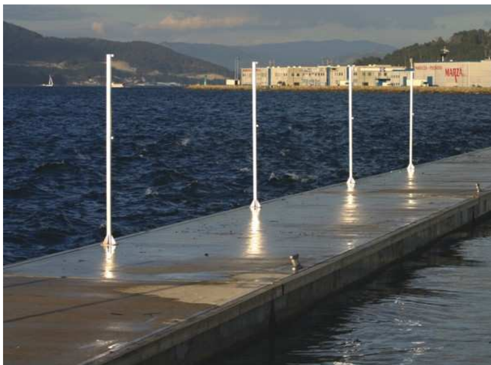
Effetto di smorzamento del moto ondoso di un molo o frangionda galleggiante
