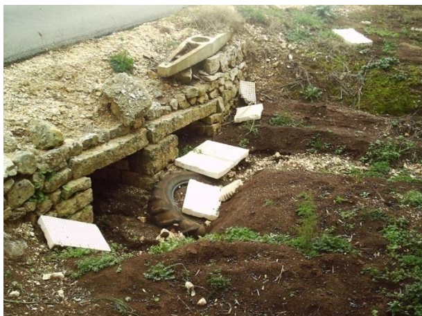
Figura 2: Tombino stradale in corrispondenza di strada Macchiarosa
