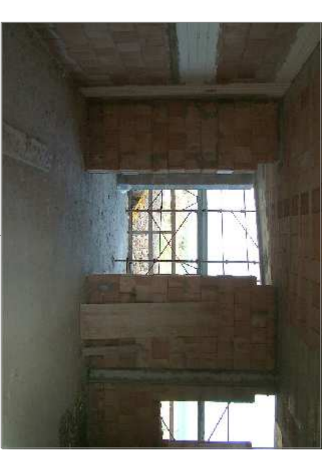
Muratura di tempio realizzata mediante MODULO FV MM4020 - 24,5 x 40 x 20
