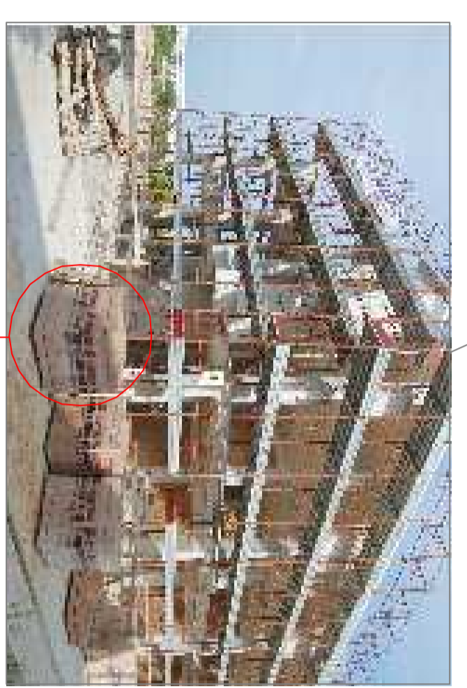
MODULO FV MM4020 - 24,5 x 40 x 20 MODULO FANTINI - SPANALICO
