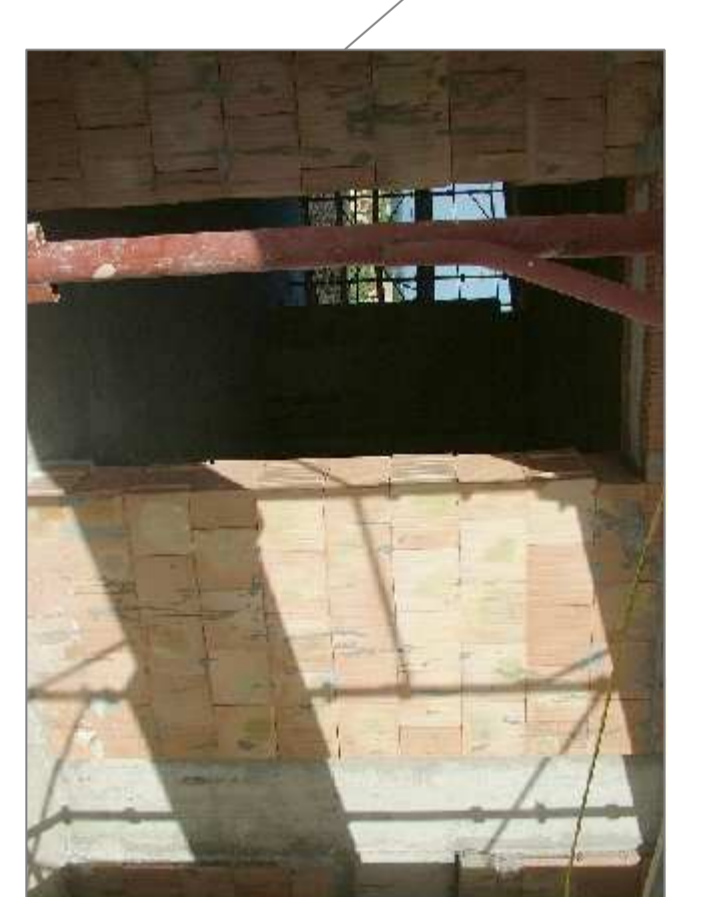
Muratura di tempio realizzata mediante MODULO FV MM4020 - 24,5 x 40 x 20
