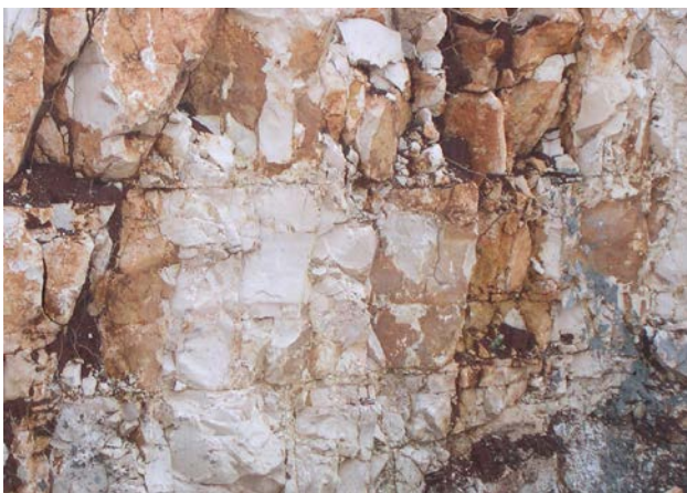
Foto 2: particolare dell'ammasso roccioso di base; si presenta massivo, con livelli debolmente alterati
