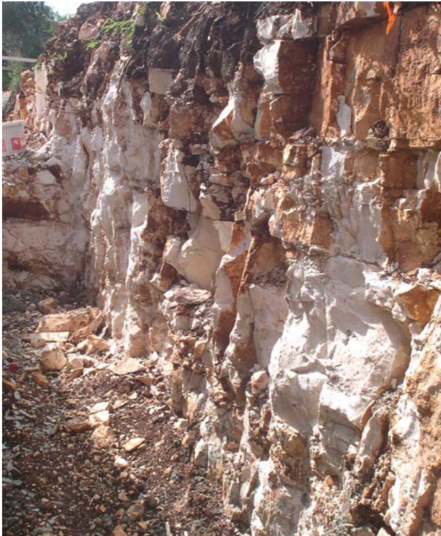
Foto 1: fronte di scavo alto circa 3 m; evidente come i livelli più superficiali, dello spessore di circa 1,5 m, si presentano fratturati con locali infiltrazioni di terre rosse
