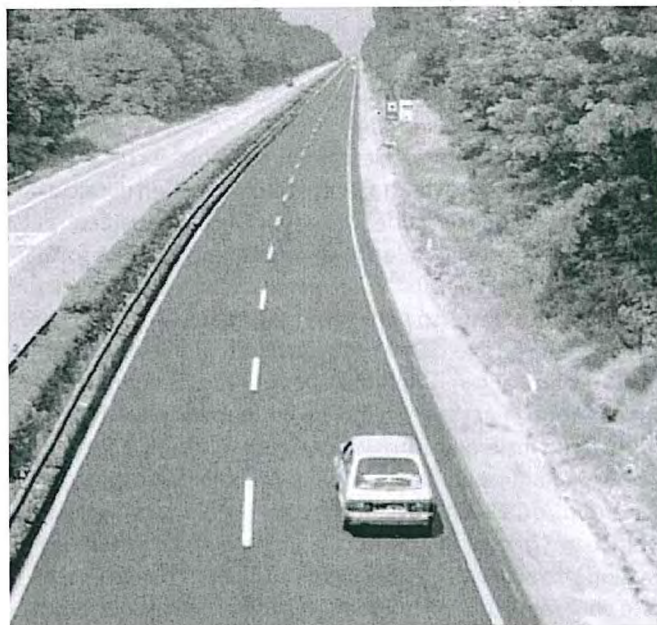
Foto 1/2/3 - Autostrada Milano-Sesto Calende: fresatura del terreno additivato con cemento GLORIT ® ; prova di piastra sul terreno trattato; a lavoro ultimato.
