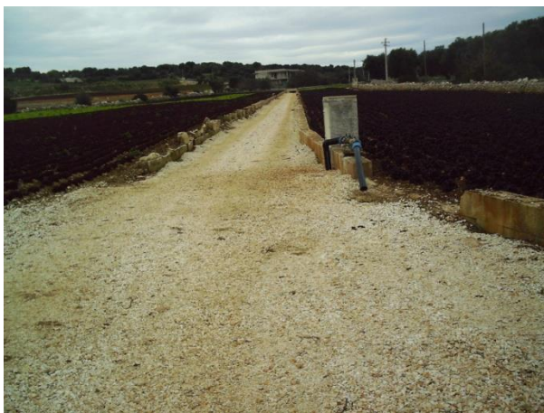
Figura 3: Tratto di canale a monte di strada S. Vincenzo
