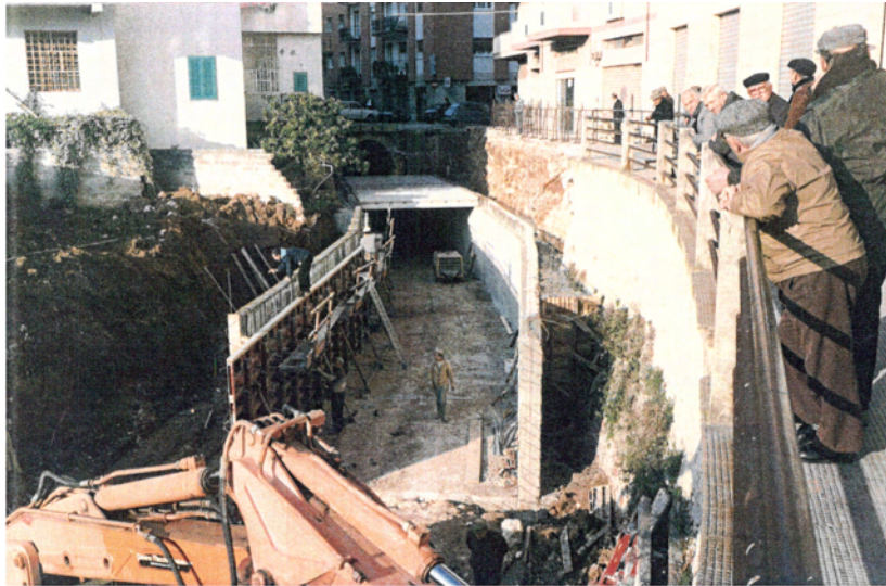
Fig. 6 – Foto storica della costruzione del collettore nel tratto di Via Marsala adiacente all’area di studio.
