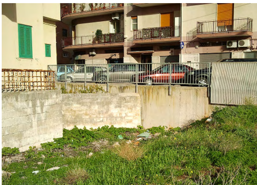
Fig. 5 – Tratto di muro in cemento armato visibile dall'area adiacente a Via Marconi.
